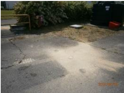
Vue du sondage S11
