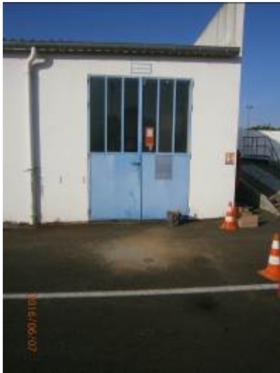
Vue du sondage S3
