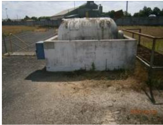
Vue du sondage S22
