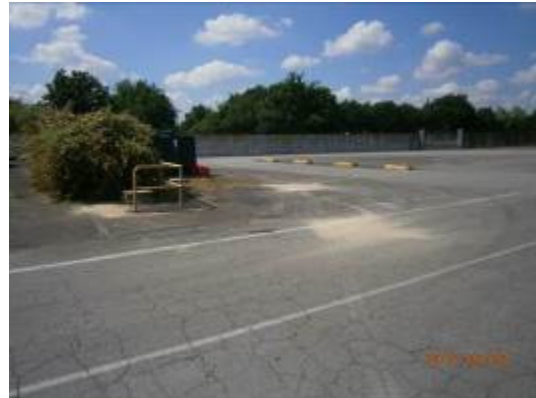
Vue du sondage S10
