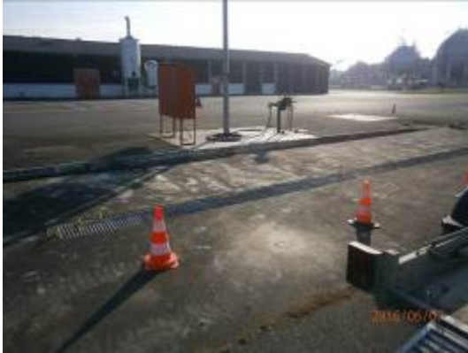
Vue du sondage S1
