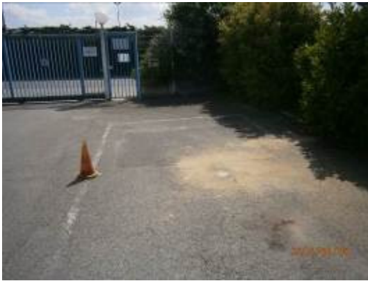
Vue du sondage S7
