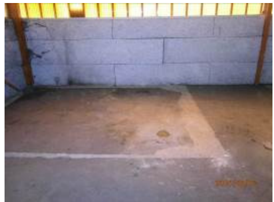
Vue du sondage S6
