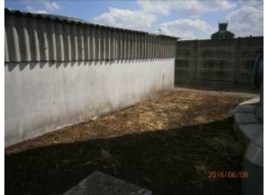
Vue du sondage S14
