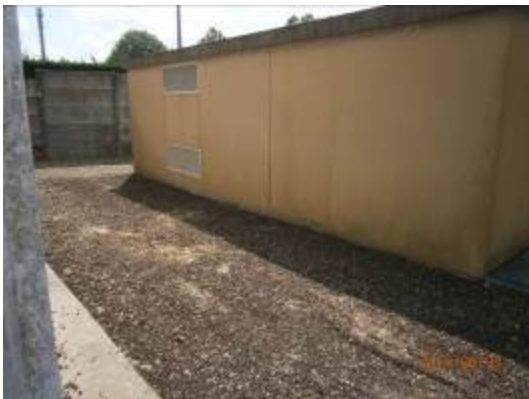
Vue du sondage S15
