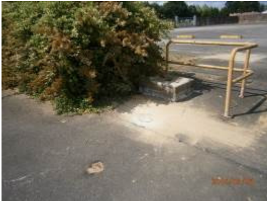
Vue du sondage S9
