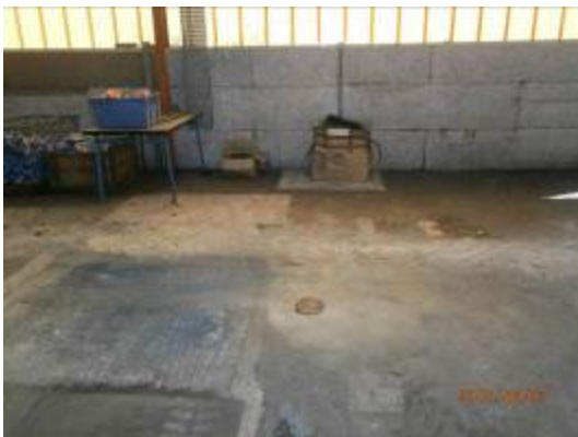
Vue du sondage S5
