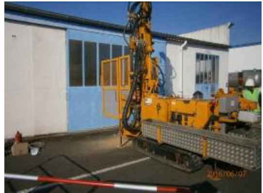
Vue du sondage S4
